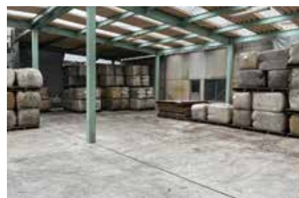
本社変電所（上）と第三倉庫（下）
