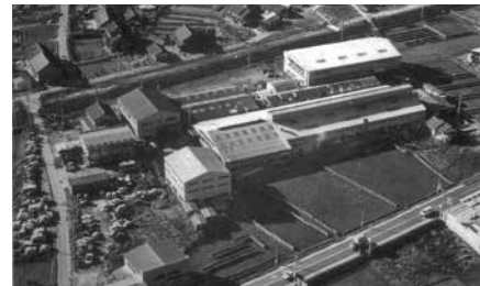
共和敷地内に移転した大府本社工場
