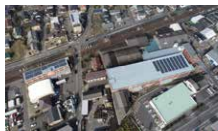
本社第一工場・第八工場の屋上に設置した ソーラーパネル
